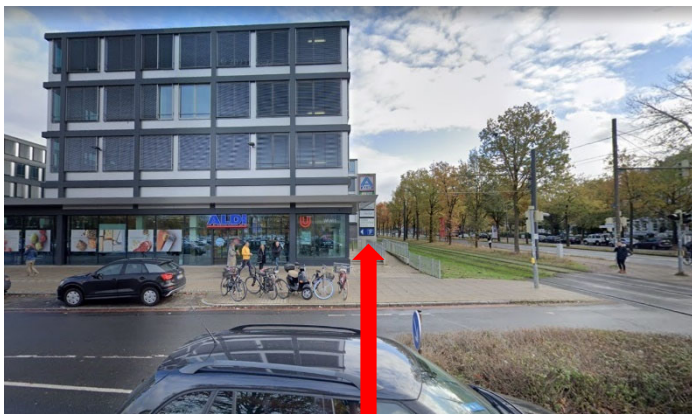
WIWI1, Tagungsgebäude mit Eingangsbereich rechts vom Parkplatz kommend
